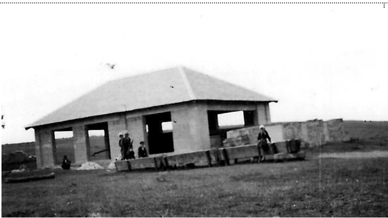
Das Bild des zweiten Brunnen im Mramoraker Sand wurde von Peter Schatz am 08.08.1938 aufgenommen. Der Brunnen ist noch gar nicht ganz fertig, auf dem Foto soll Peter Feiler sein.
